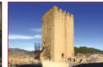
Torre del Homenaje de la Fortaleza de Uncastillo
