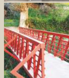
Puente sobre el Arroyo de Salar en el Parque Carolina Trassierra Nieto
